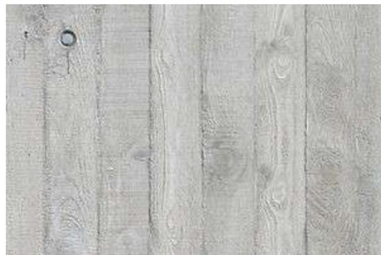
*Béton imprimé « planches de bois »*
